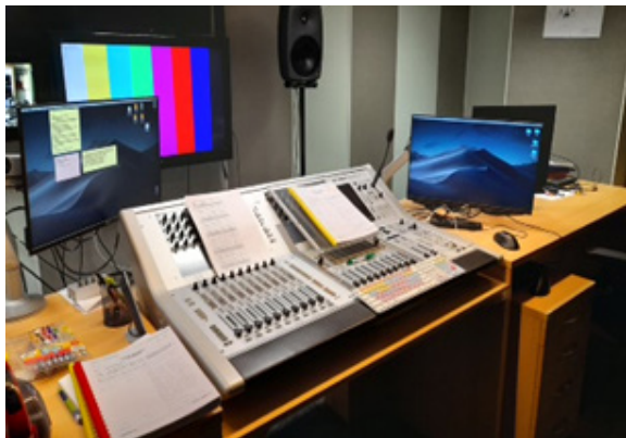
Pracoviště před rekonstrukcí
